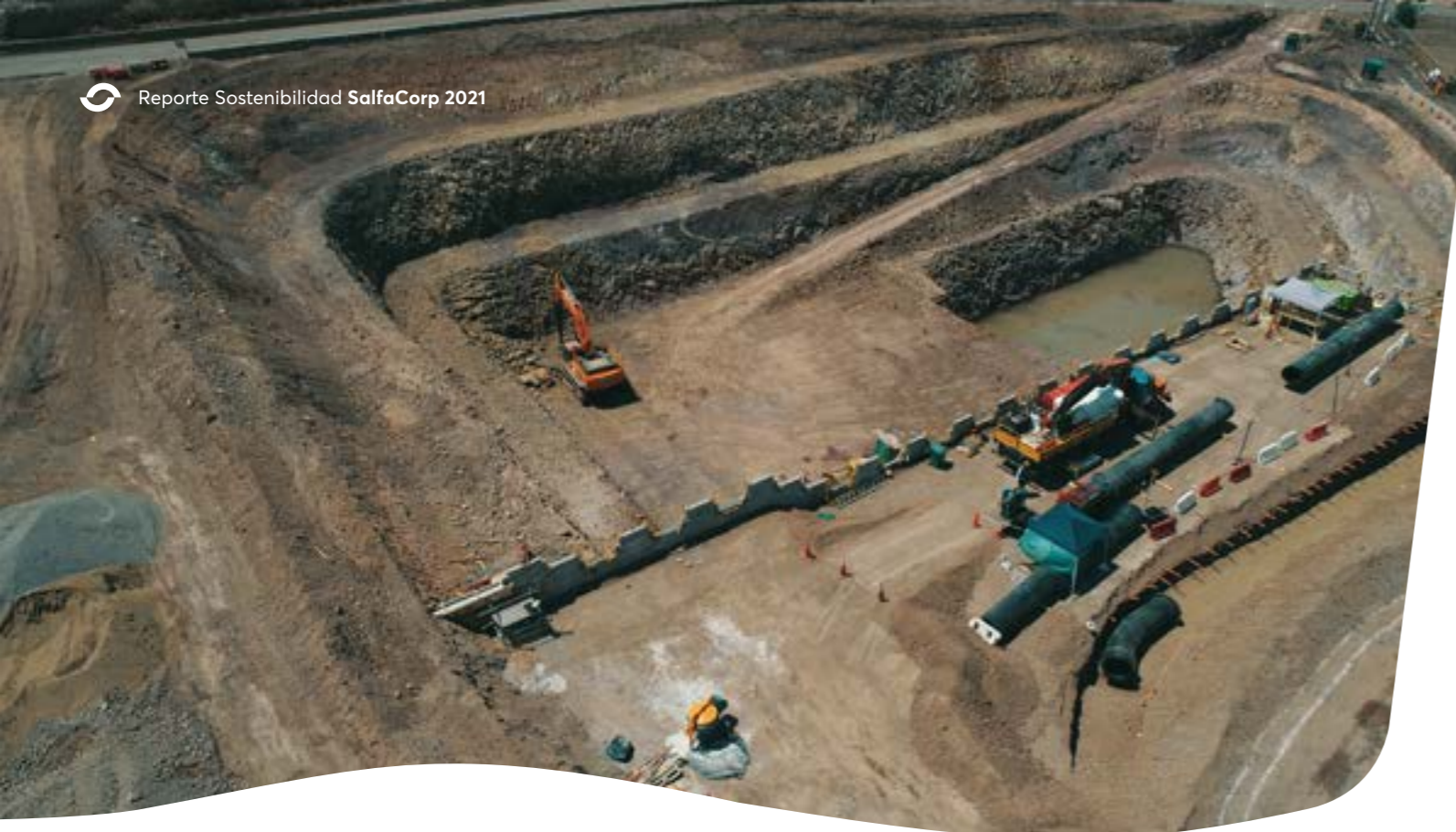
Anglo American Sur - Las Tórtolas, Movimiento de Tierra Masivo de Espesamiento de Relaves Planta 1, Colina, RM, Chile.
