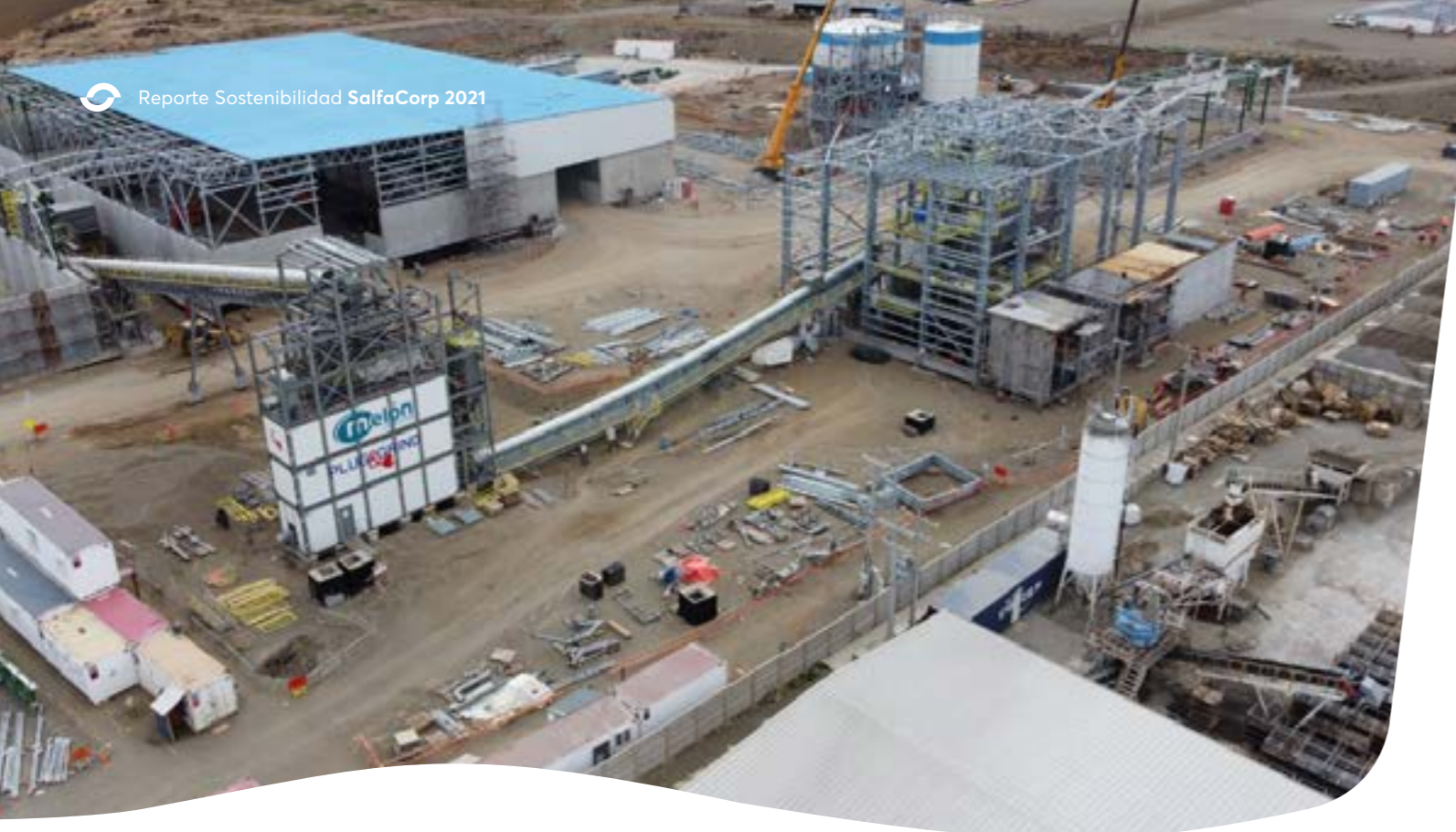
Melón S.A., Construcción de Obras Civiles, Montajes y Bodega de Materias Primas, Planta de Cemento Melón - Punta Arenas, Punta Arenas, XII Región, Chile.
