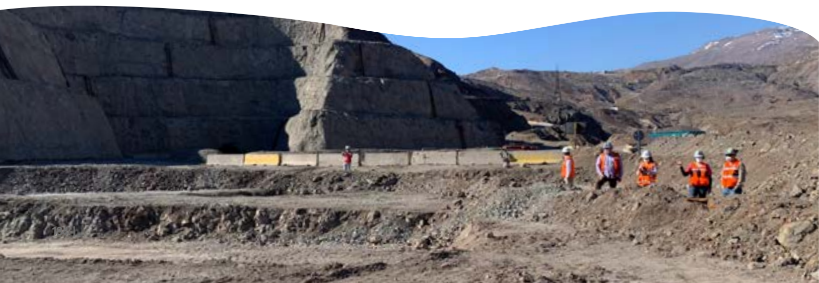
Codelco División El Teniente, Construcción y Montaje S/E Traful y Línea de Derivación 110Kv Minero - Traful y Trful, Sewel - Rancagua, VI Región Chile.
