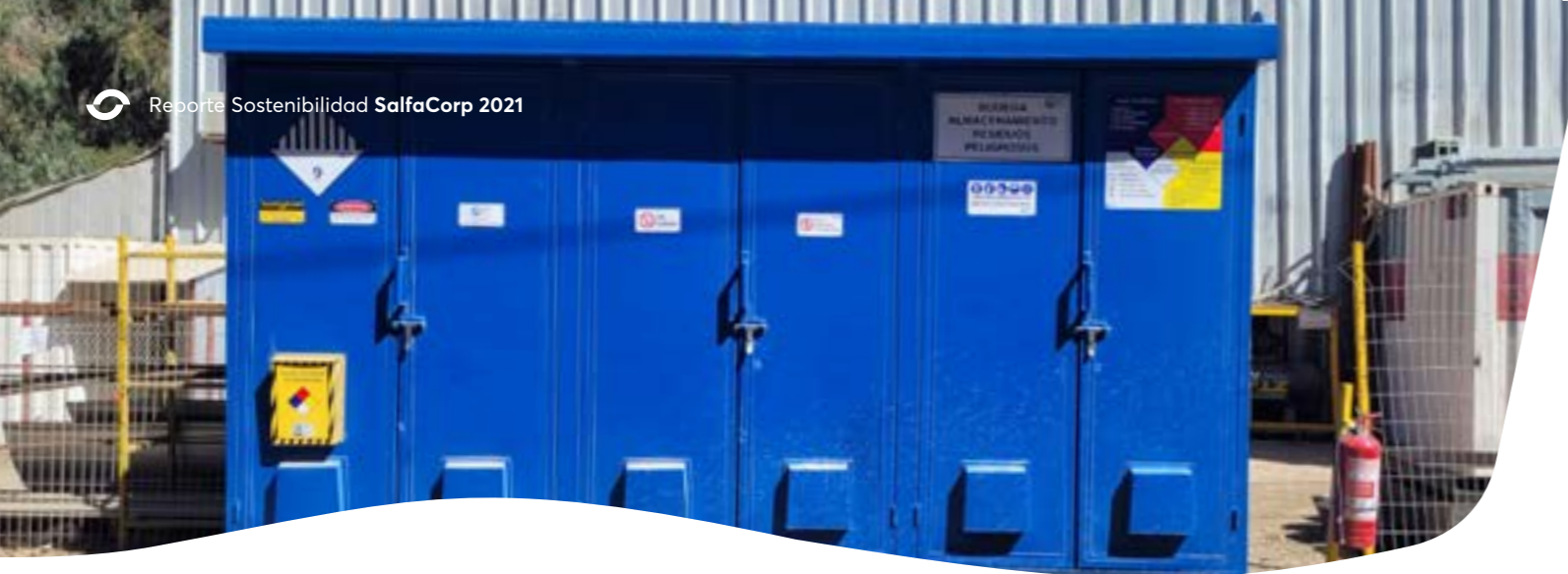
Yamana Gold - Minera Florida, Bodega de Almacenamiento de Residuos Peligrosos en proyecto Servicio de Transporte de Mineral y Estéril, Alhué - Melipilla, RM, Chile.
