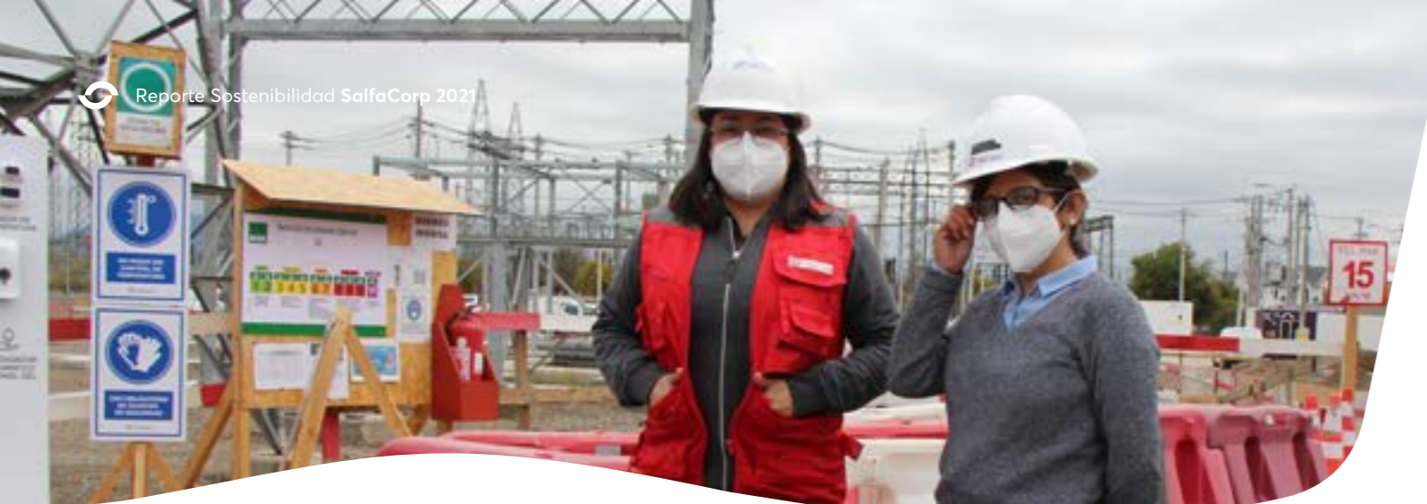
ENEL, Construcción de Edificio Centro de Excelencia Operativa (CEO), Lampa - Santiago, RM, Chile.
