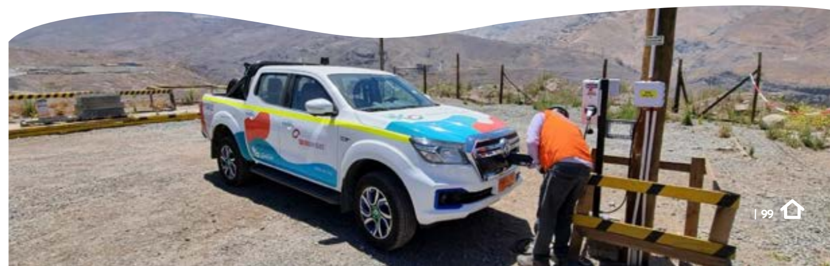
Camioneta Electromovilidad en Codelco División El Teniente, Construcción y Montaje S/E Trafal y Línea de Derivación 110Kv Minero - Trafal y Trful, Sewel - Rancagua, VI Región Chile.
