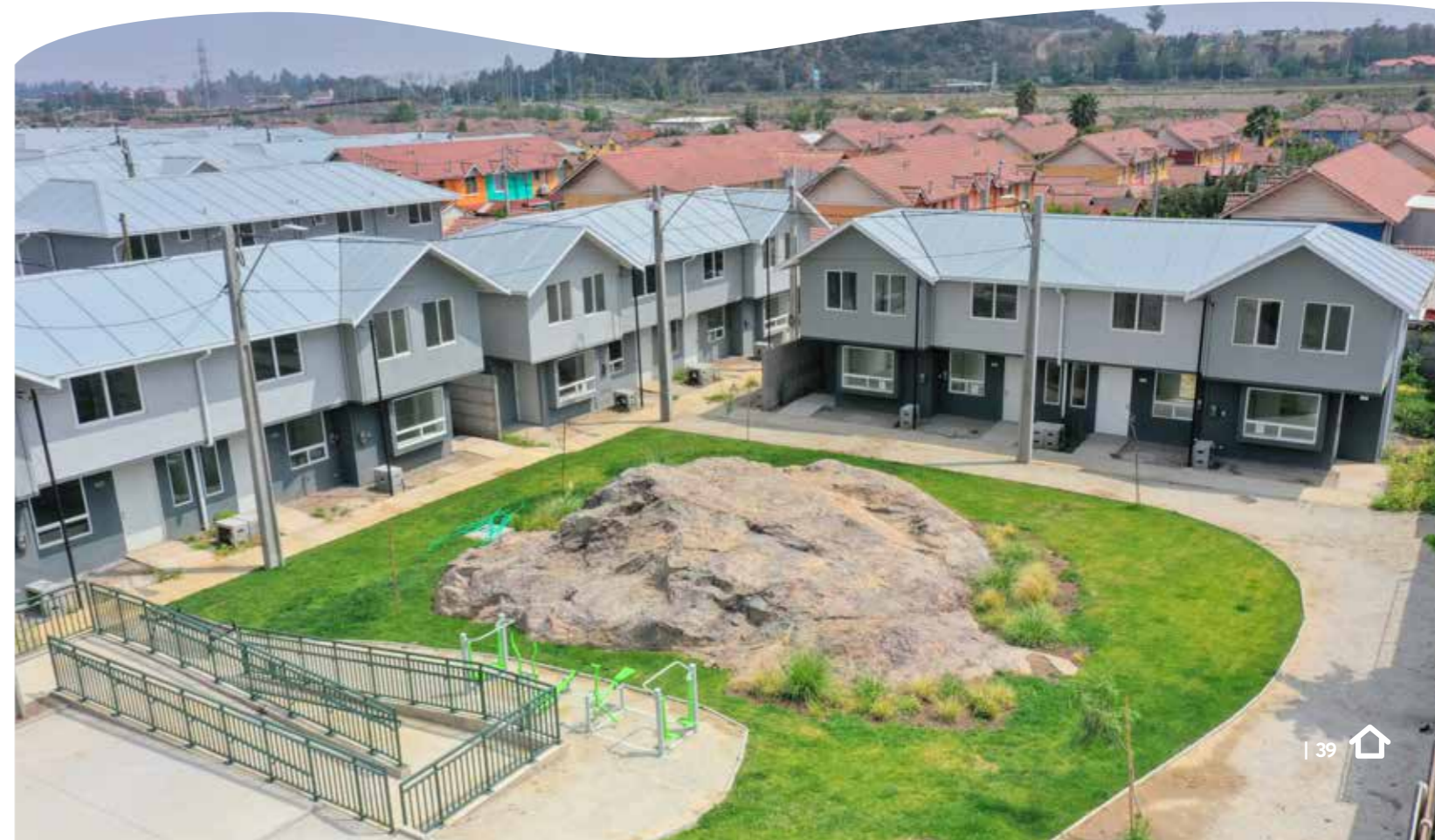
Condominio Vista del Maipo II, Puente Alto - Santiago, RM, Chile.
