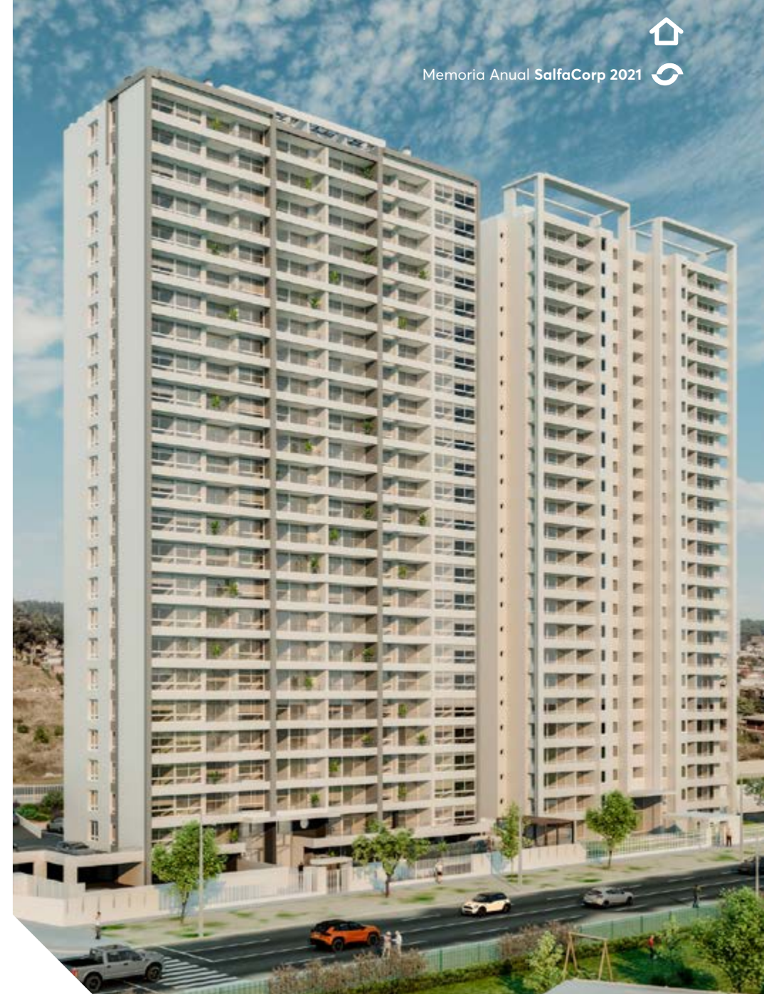
Edificio Parque Bellavista II, Concón, V Región, Chile.
