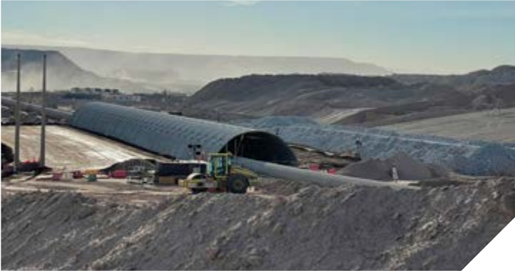
Construcción y Montaje CC-001. Proyecto Spence Ripios Dam Capacity (SRDC)
